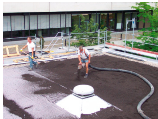
Základní druhy substrátů se většinou dopravují na střechy pneumaticky
